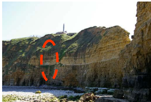
Façade Est, décompression
